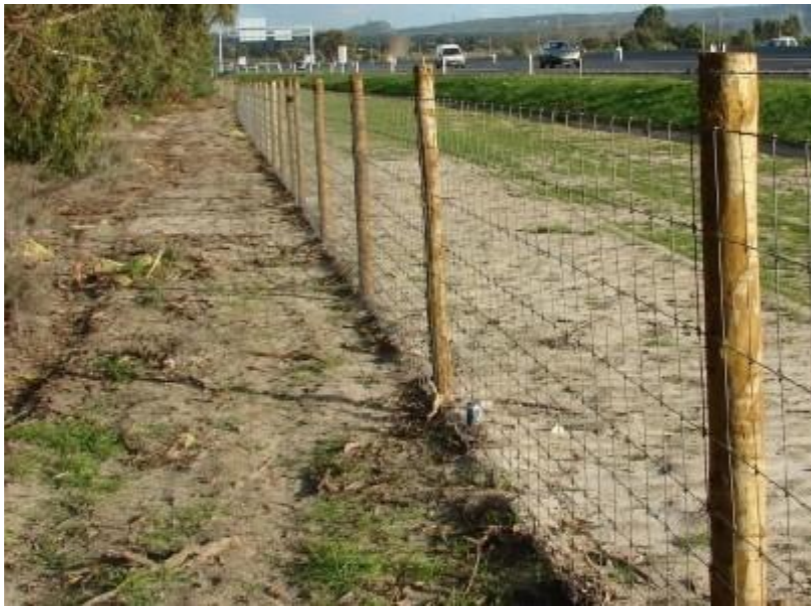
Photo 5 : Exemple de clôture avec grillage mouton et piquets en bois
